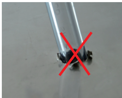
Abb. 8: Verbotene Verlegung, Bohrung ist nicht entgratet, eine Tülle o. Ä. fehlen.
