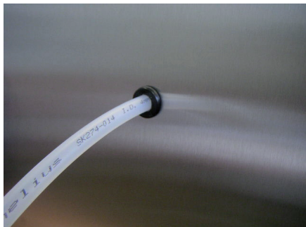
Abb. 7: Geschützte Verlegung der Gasleitung
